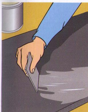
Используйте гибкий шпатель при нанесении клея "K-FLEX" на большие поверхности. Если Вы приклеиваете материал "K-FLEX" по всей площади, вначале нанесите клей на изоляционный материал, а затем на поверхность. Когда клей достаточно просохнет, наложите лист на поверхность и сильно прижмите на короткое время.
